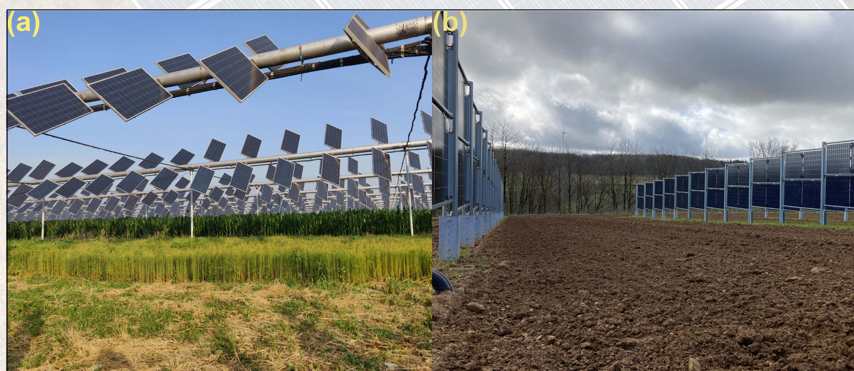
Abbildung 1. (a) aufgeständertes APV-System, (b) vertikal bifaziales APV-System [1]
