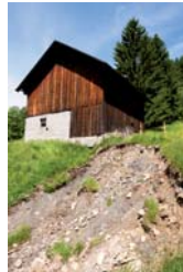
Fig. 1: Shallow landslide in Laterns, Vorarlberg. Photo: T. Zieher, 19.06.2013
