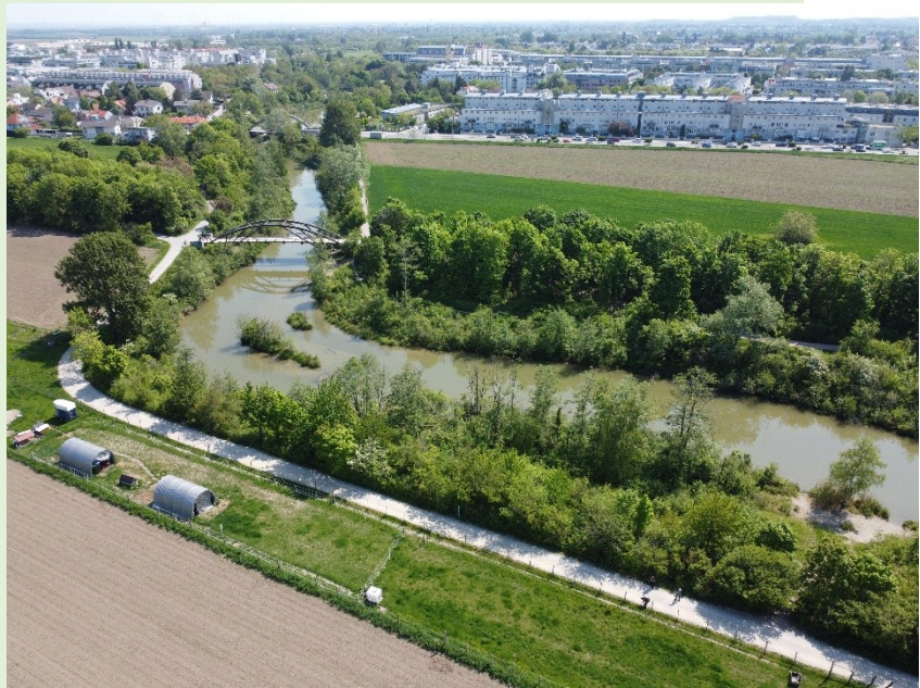
Abschnitt in Wien mit Strukturen (Inseln) im Gewässer © Betriebsgesellschaft Marchfeldkanal
