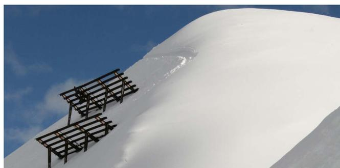
Am Beispiel der Lawinenverbauungen: Der Zustand der ca. 550 km von der Wildbach- und Lawinenverbauung errichteten Stahlschneebrücken wird regelmäßig geprüft und je nach Schadensintensität und Funktionsbeeinflussung gewartet.
